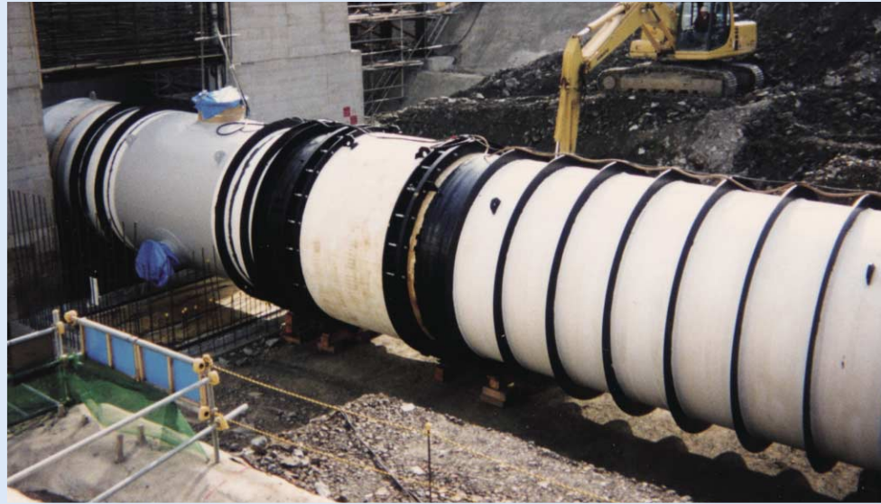
●四国電力株式会社 橋湾火力発電所(1998年) 3700A 取放水及び循環水管
