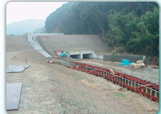
上水道角型水路
