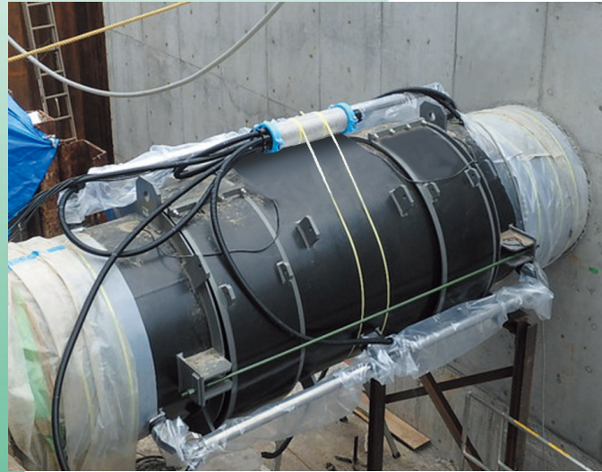
ヴィクセンサーII付き伸縮可とう管 Flexible expansion pipe with VIC SENSOR II
