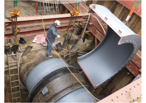
リベアスリーブの施工状況 Installation of repair sleeves.
